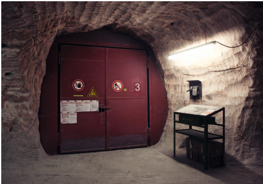
1,6 Milliarden Euro kosteten die Erkundungsarbeiten in Gorleben bisher, nun ruhen sie
